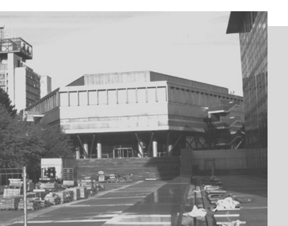
Gebäude des Fachbereiches Physik der ETH auf dem Högberg
